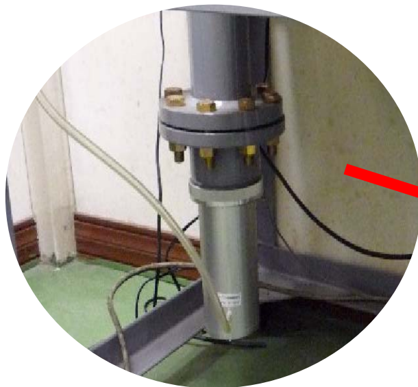
Orifice flow meter
